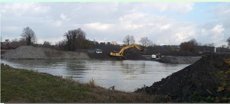
Depuis environ un mois, les travaux préparatoires vont bon train, avec la mise en place des clôtures de la nouvelle zone à exploiter et des panneautages, le début du décapage avec la création d'un merlon autour demandé pour éviter de capturer le plan d'eau lors d'une crue décennale par le Gave.
